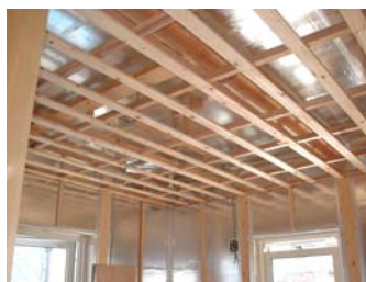
2F 洋間天井下地
