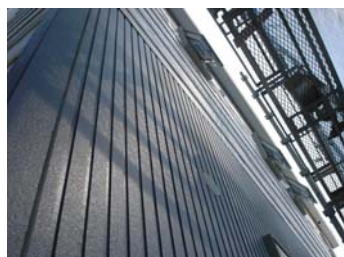
サイディング張り状況
