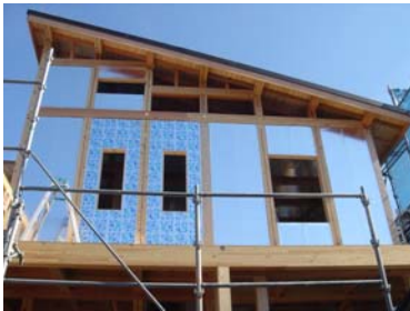
F P 壁パネル取付状況
